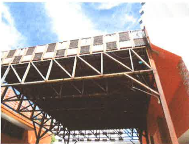
โครงหลังคาเหล็กด้านหน้า
